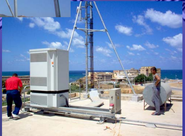
Construction des Sites Radio sur Terrasse.
